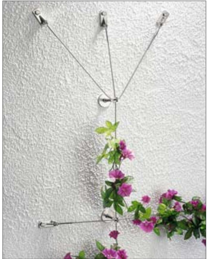
**Oberer Befestigungspunkt mit 3 Befestigungsdübeln und Querverspannung zur Abfangung des Seitenwindes**
