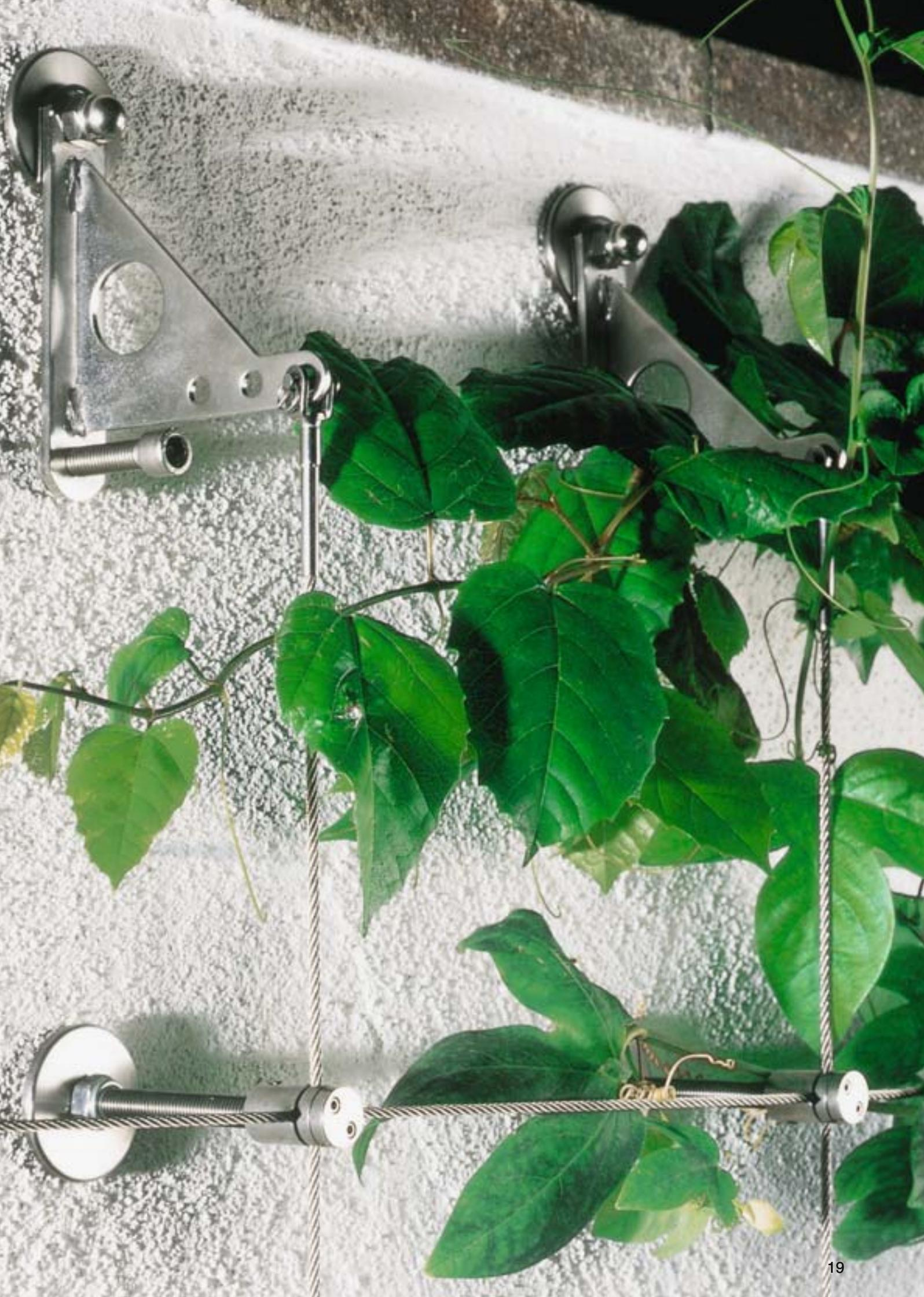
Rankgerüste müssen so stabil sein, daß sie das Gewicht der Pflanze im ausgewachsenen Zustand und alle darauf einwirkenden Kräfte aufnehmen können. Gleichzeitig sollte das Rankgerüst die gleiche Lebenserwartung aufweisen, wie die Pflanze selbst.
